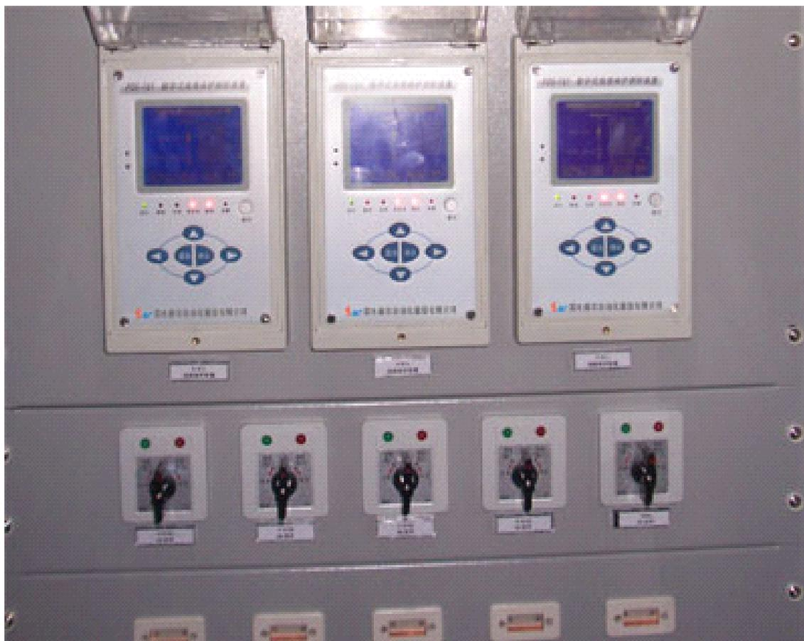
图 9、PDS-760 系列装置集中安装图
