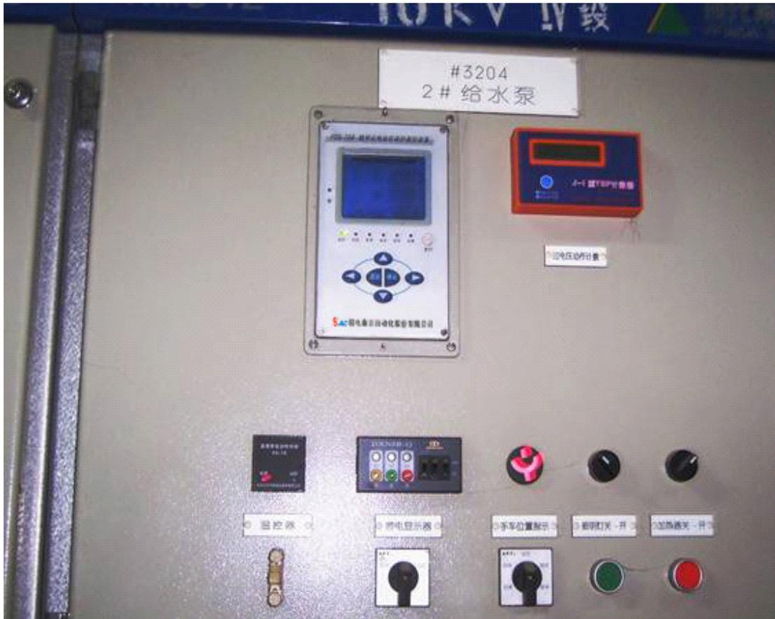
图 10、PDS-760 系列装置分散安装图
