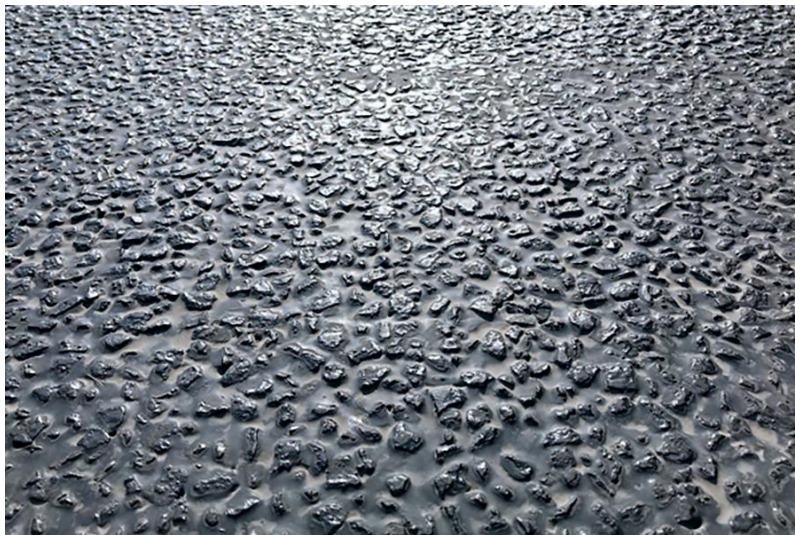
半柔性（抗车辙）路面面层实拍图
